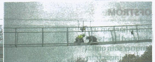
En bild från bygget av hängbron. FOTO: JOHAN HULTGREN
